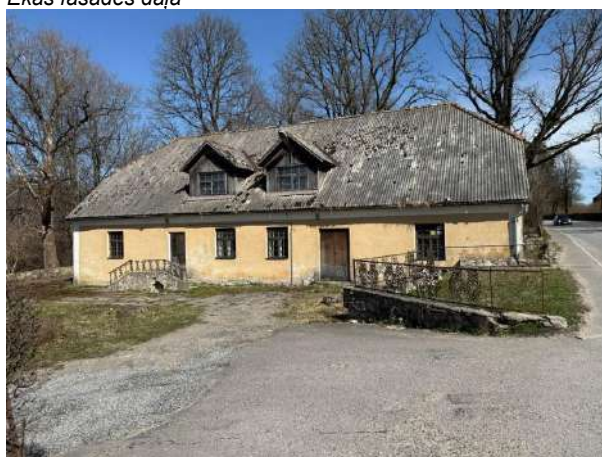
Ēkas fasādes daļa
