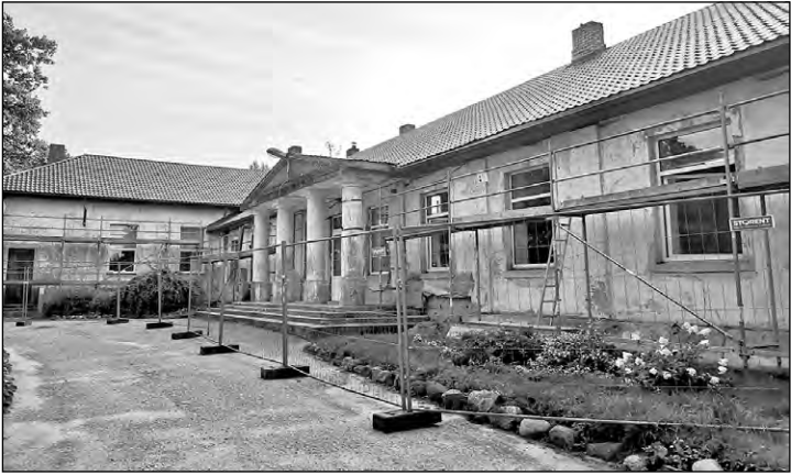
Uzsākti fasādes renovācijas darbi Rozulas tautas namam. Foto: Iluta Balode
